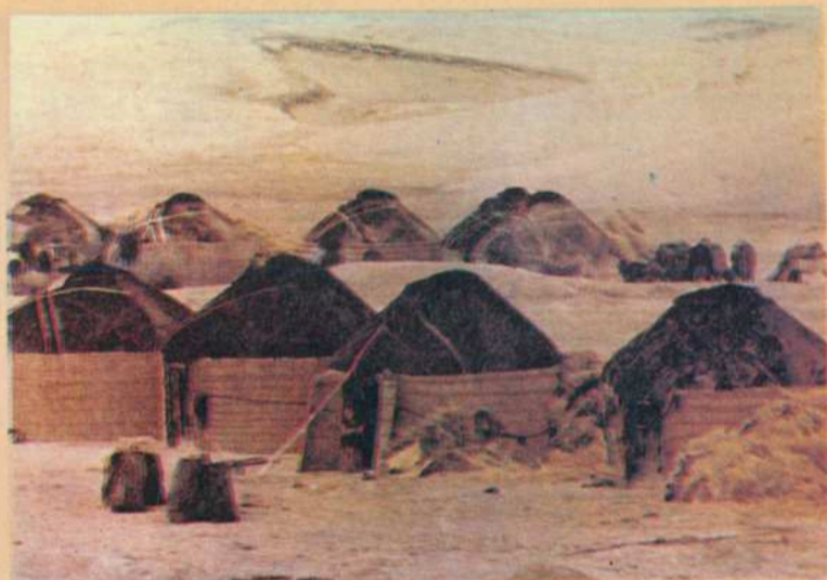
Pouzdana skloništa od drvenog kostura pokrivenog klobučinom ili kožom: Jurte, danas u upotrebi kod sibirskih i mongolskih naroda, koristili su stalno nastanjeni Skiti; nomadi su učvršćivali sličan šator na kolima
