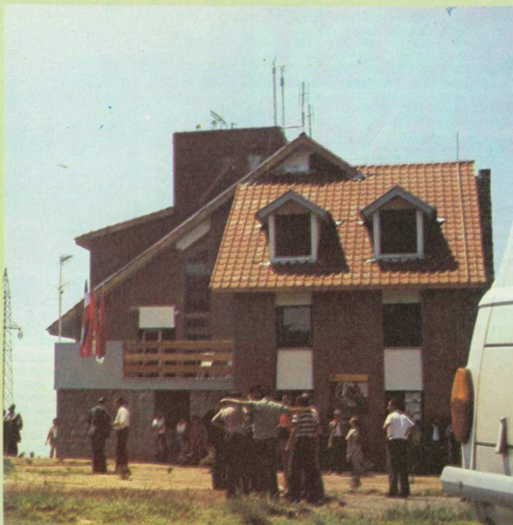
Moderna zgrada, ali nedovoljna oprema: Meteo-stanica na Kopaoniku
