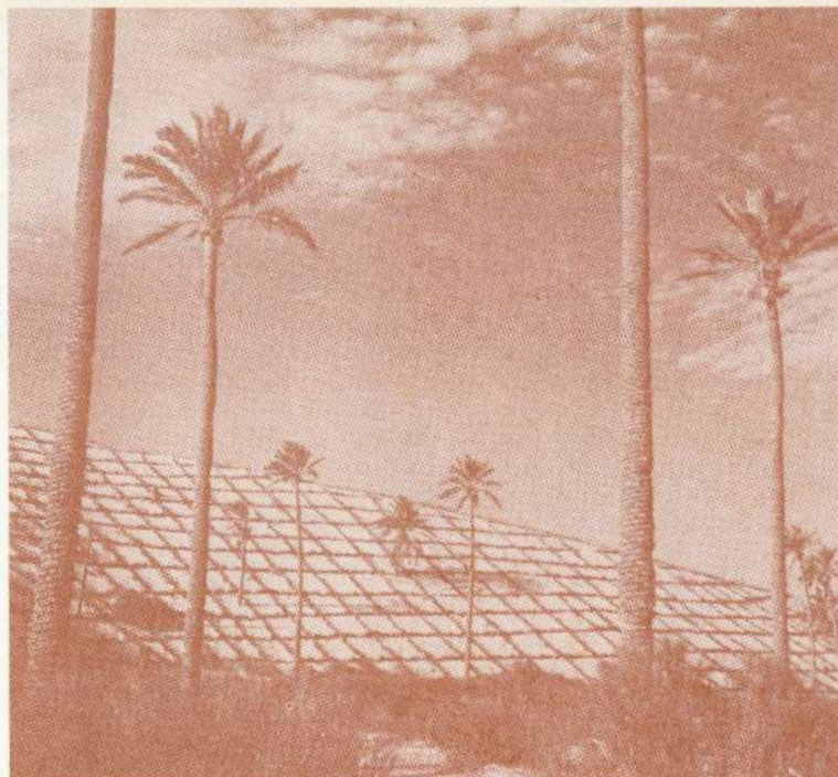
Mere za obuzdavanje peščane stihije: Blizu Misurata u Libiji mreža od sasušene trave zadržava klizanje peska na palme
